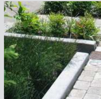
betoonserv kinnistel vihmapeenardel
