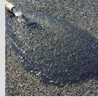
poorne asfalt kaherealisel sõiduteel
