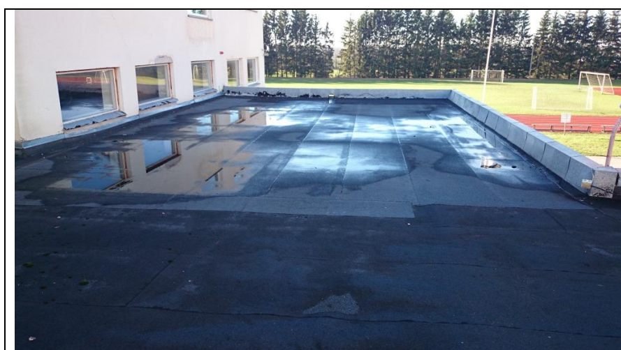
Pilt 12. Katusel puuduvad korralikud kalded ja vee äravool pole tagatud(vee ärvool taga otsas).
