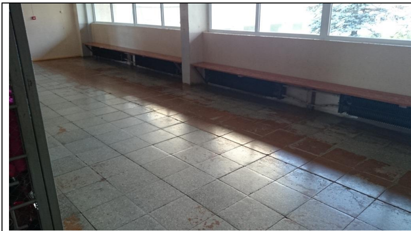
Pilt 25. Vanad radiaatorid, mis ei ole reguleeritavad.
