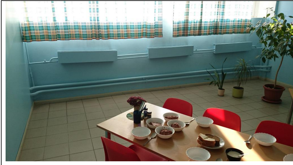
Pilt 24. Vanad radiaatorid, mis ei ole reguleeritavad.
