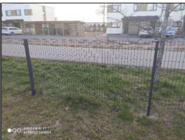
Foto 2. Lubatud metallist paneelaia visuaal (Door Build OÜ)
