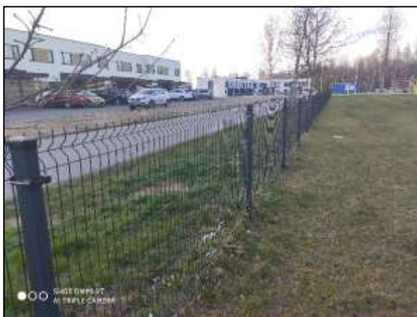
Foto 1. Lubatud metallist paneelaia visuaal (Door Build OÜ)
